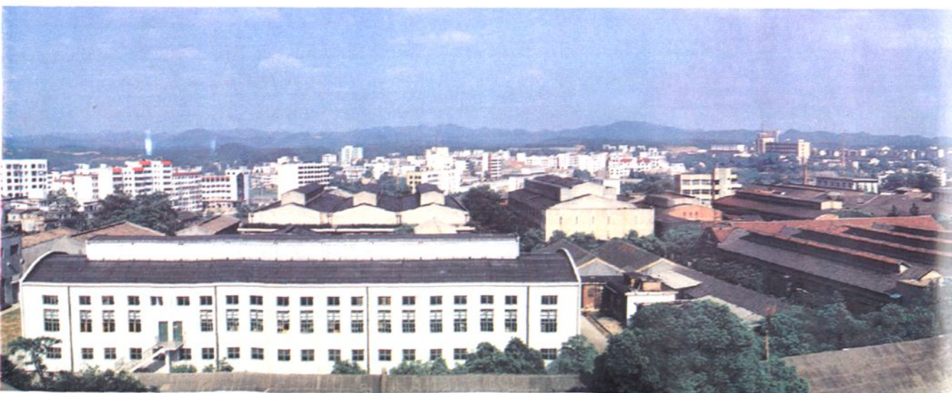
股份公司生产区全貌(位于新华西路119号的老厂区)
