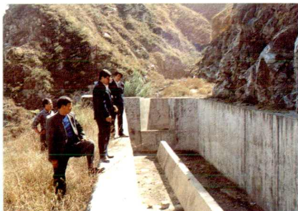
建设中的大柳树水电站
