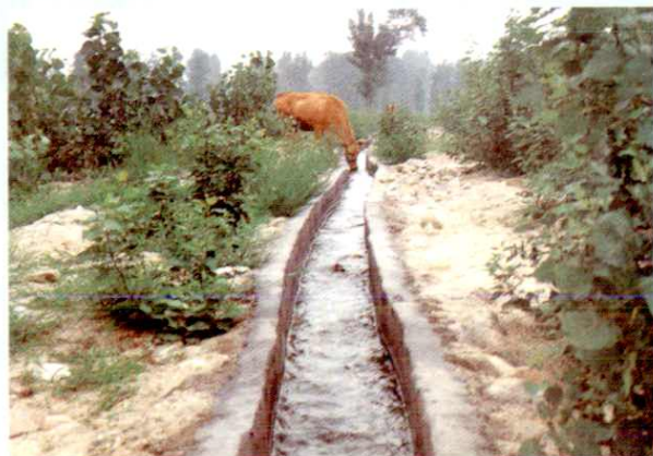
浇地采用防渗措施，灌溉条件大大改善
