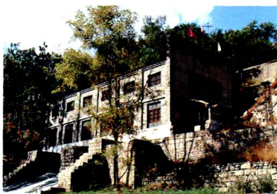
陡岭台水电站外景
