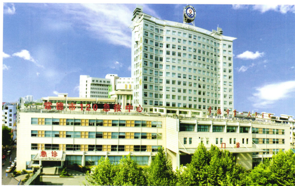
现代化的门急诊医技大楼
