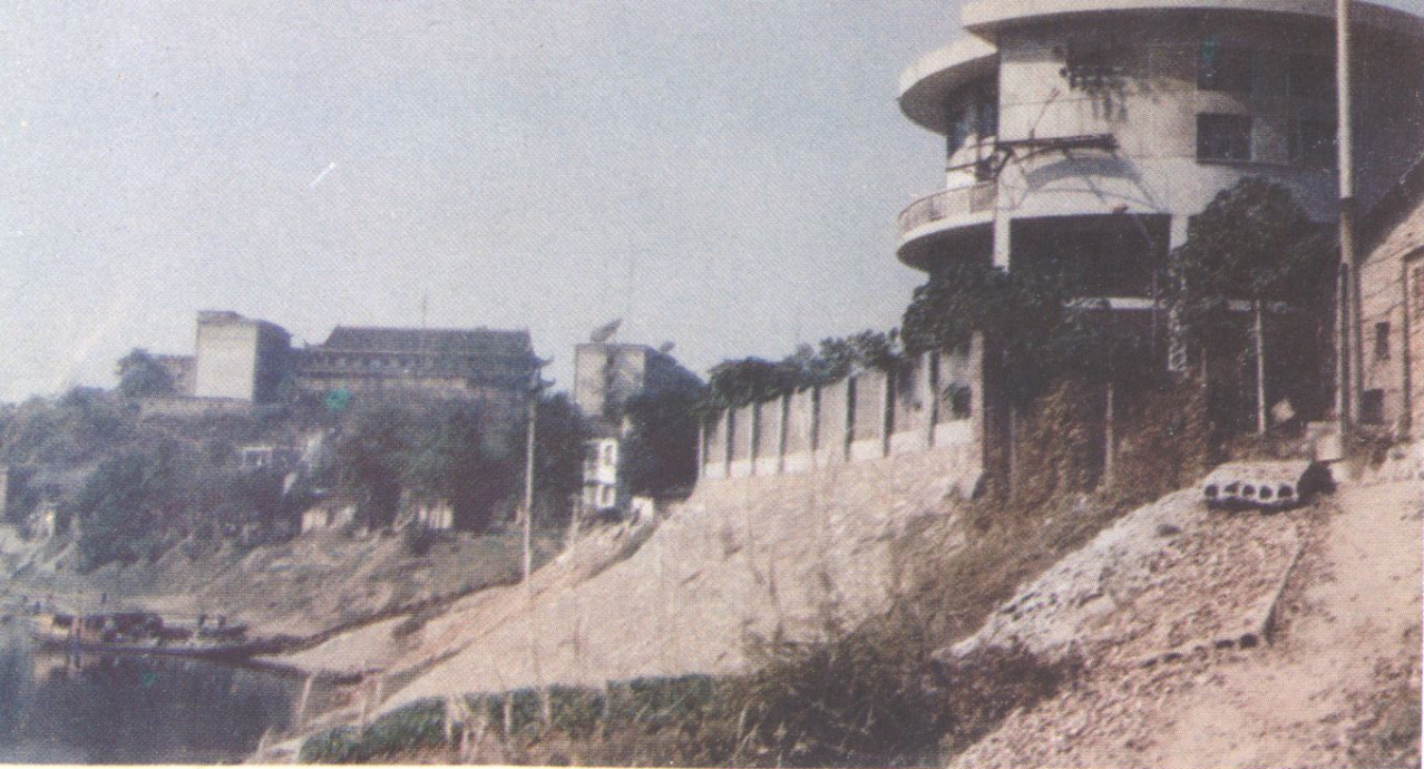
县自来水 厂取水泵房
