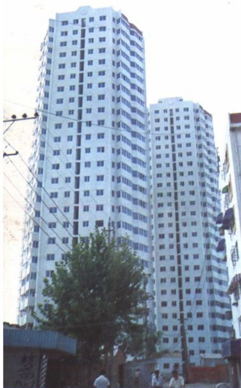
▲承建的南京洪武路 25 层高级公寓(外地下室),被南京市评为“优良工程”。
