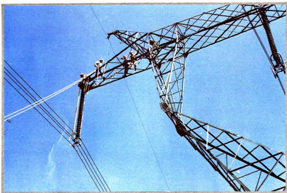
工作人员正在为500千伏超高压输电线路换瓷瓶
