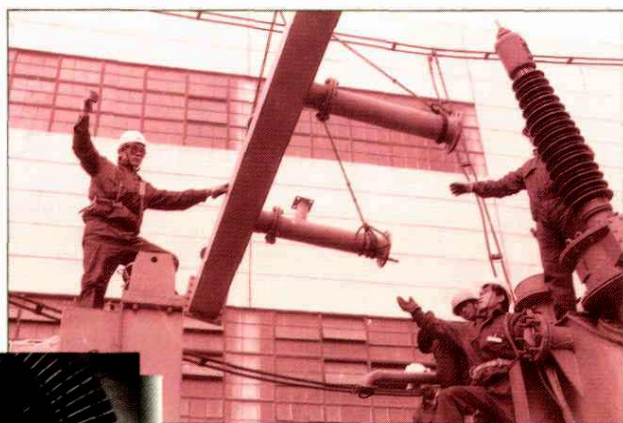
检修人员对20万千瓦机组主变压器(上)和汽轮机组(下)进行维修。
