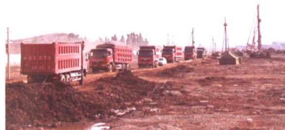
建设中的环湖南路石寨路段
