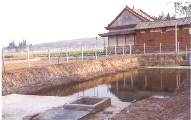
新建投入使用的段七村湿地污水自然净化基地。
