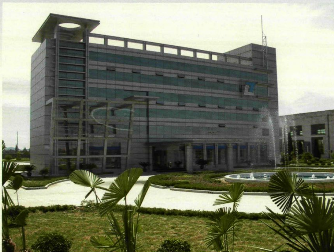
当涂供电公司多经企业——力通电气工程公司综合楼
