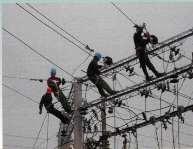
外线工人作业
