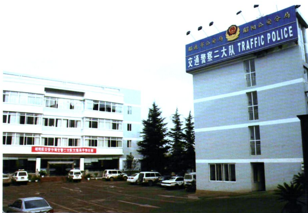
2006年昭阳区交警二大队新建办公大楼
