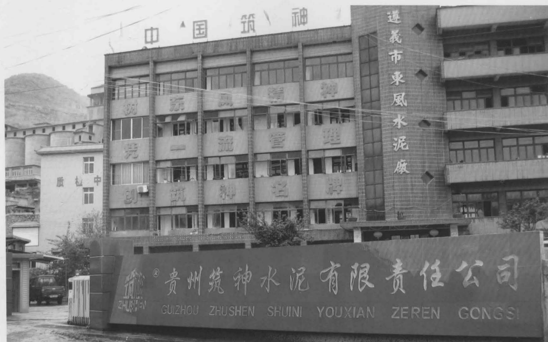
图 - 14 2005年，贵州筑神水泥有限公司
