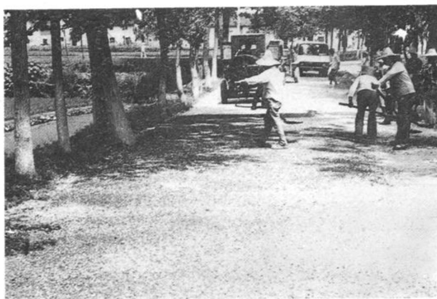
铺装油渣路面
