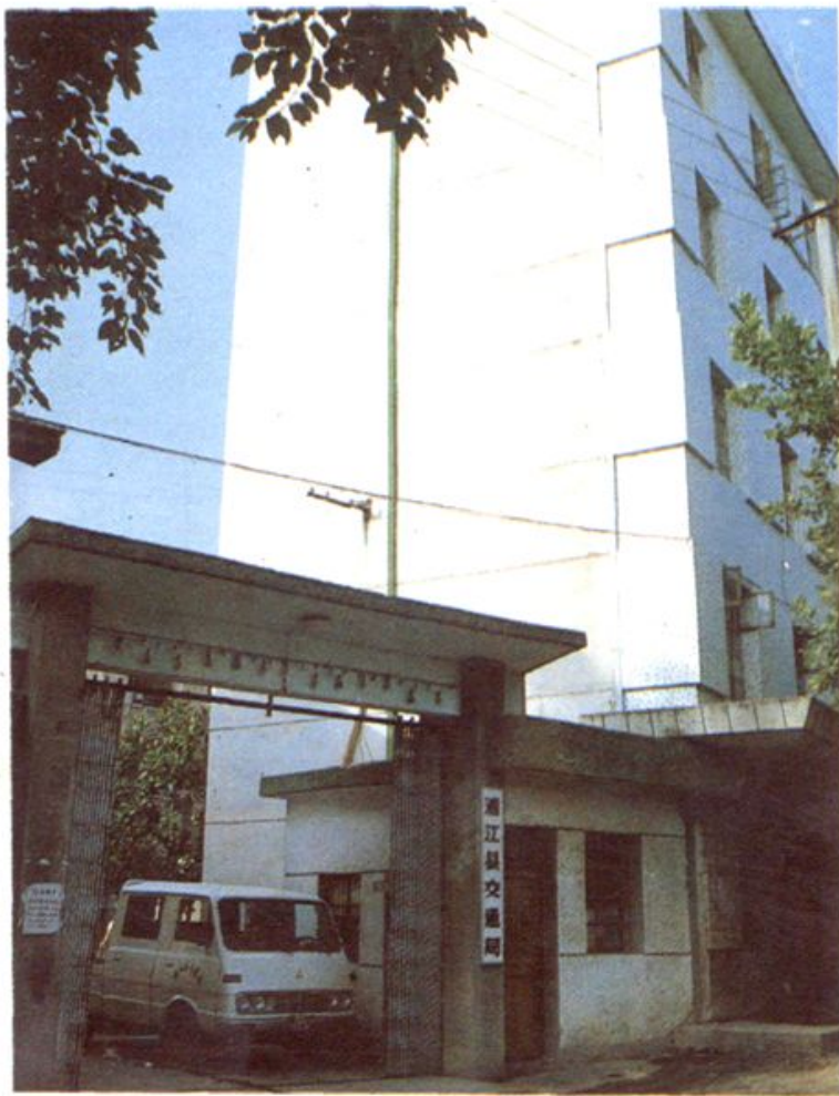
交通局办公楼
