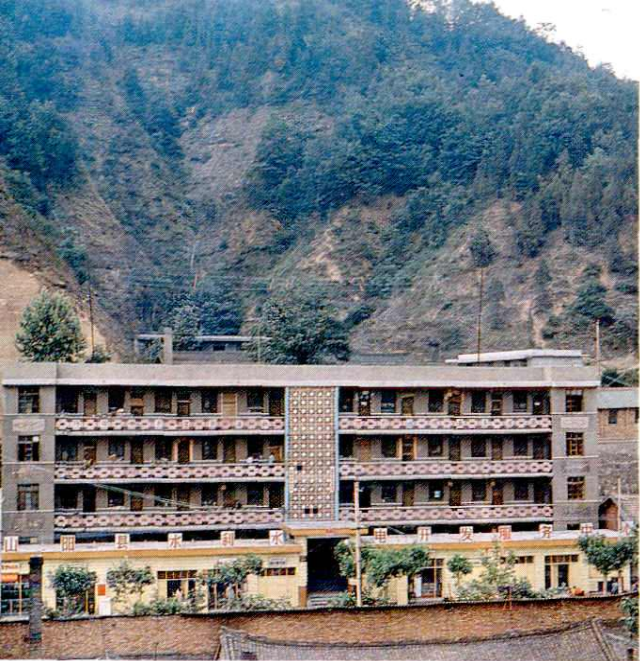
水利水土保持局办公楼
