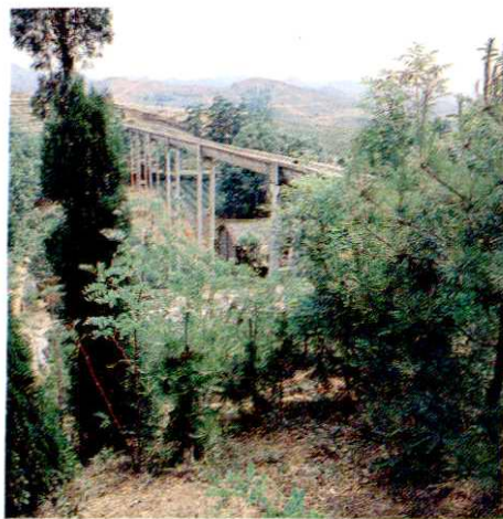
西沟水库西干渠行架U 渡槽
