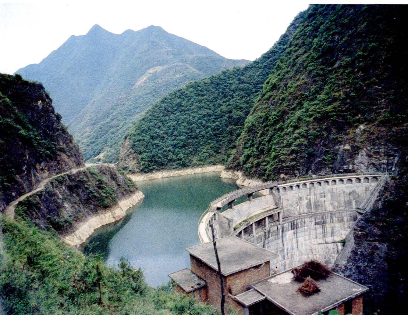
西沟水库枢纽工程
