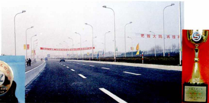
▼ 浦花建筑公司承建的远东大道工程获市和国家金奖
