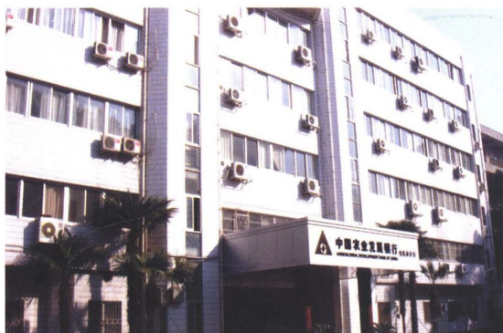
坐落在安庆市人民路上的农发行安庆市分行办公大楼。
