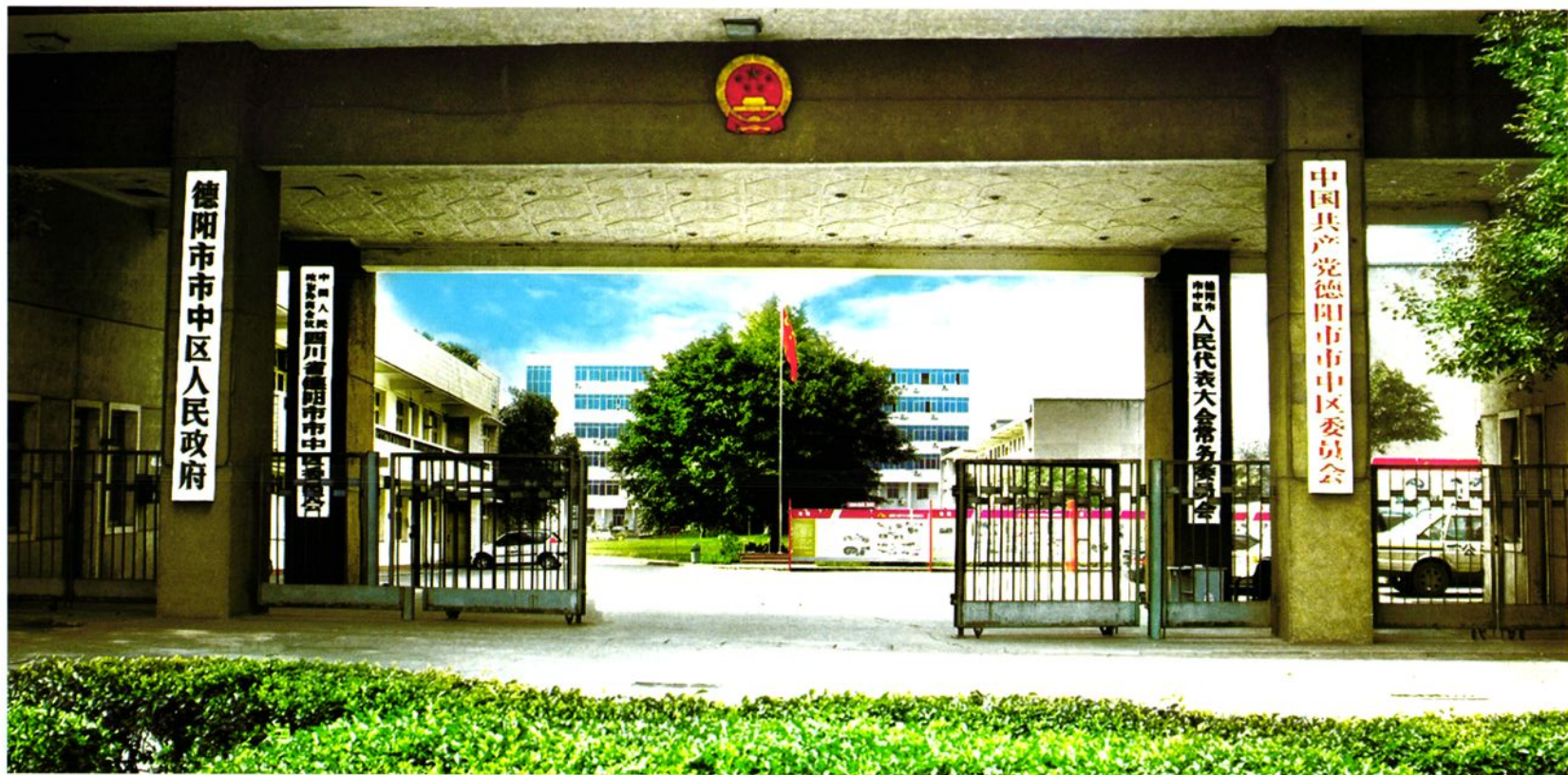
中共德阳市市中区委、区人大、区政府、区政协大门
