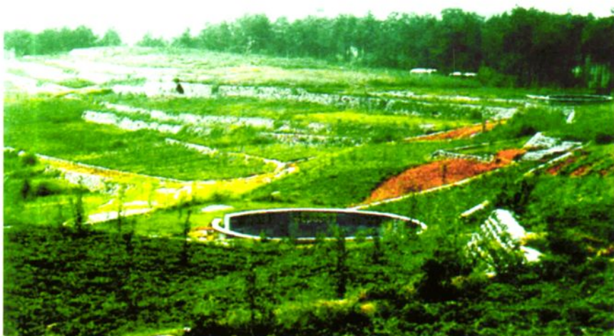
丘陵乡镇坡改梯地示范工程
