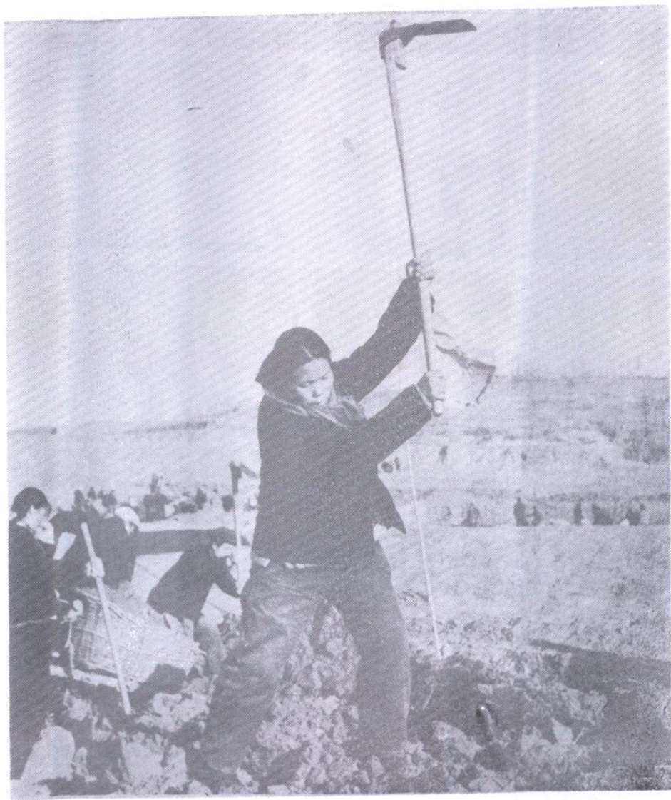
农田基本建设施工现场
