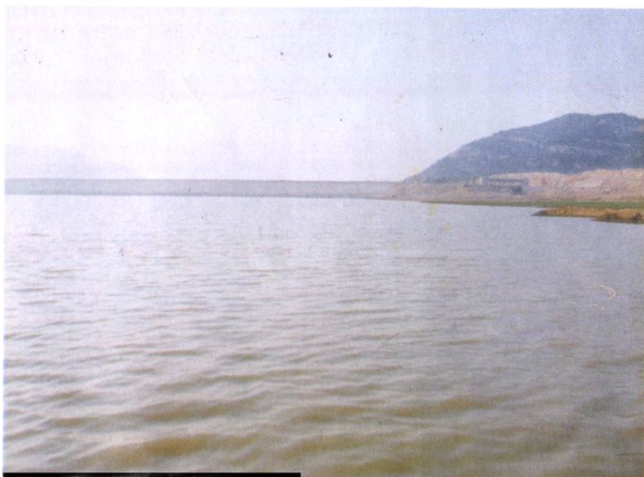
大型蓄灌工程—尼山水库
