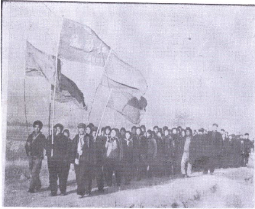
水利施工队伍开赴工地
