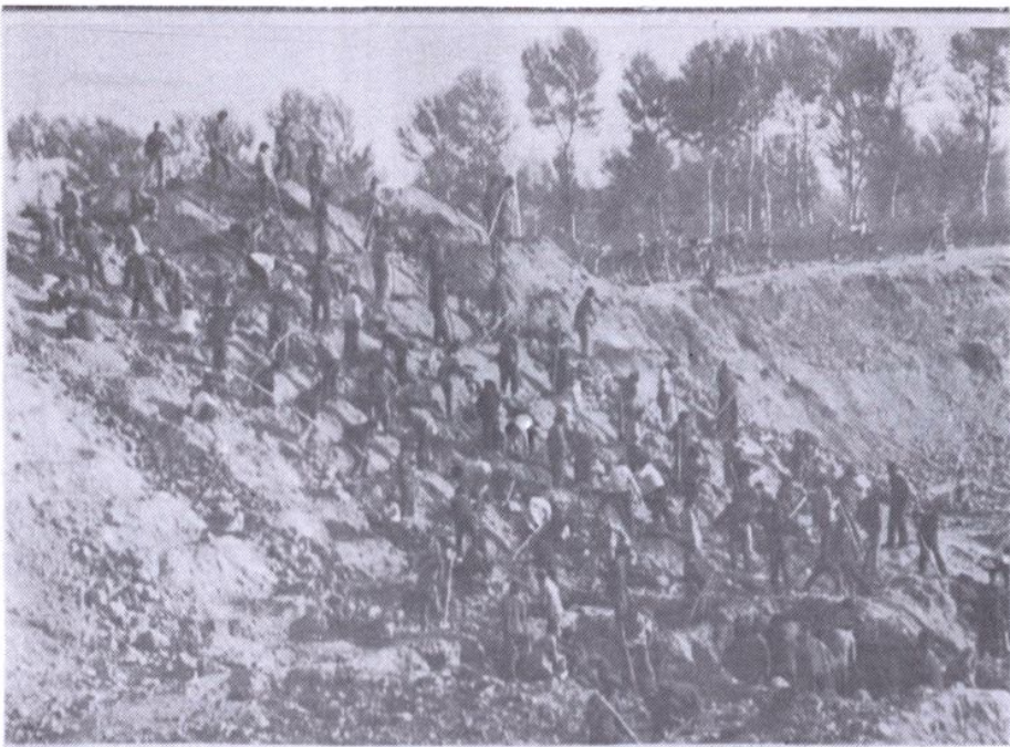
开挖蓄水工程现场
