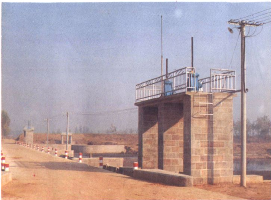
地下水回灌工程—官寨闸
