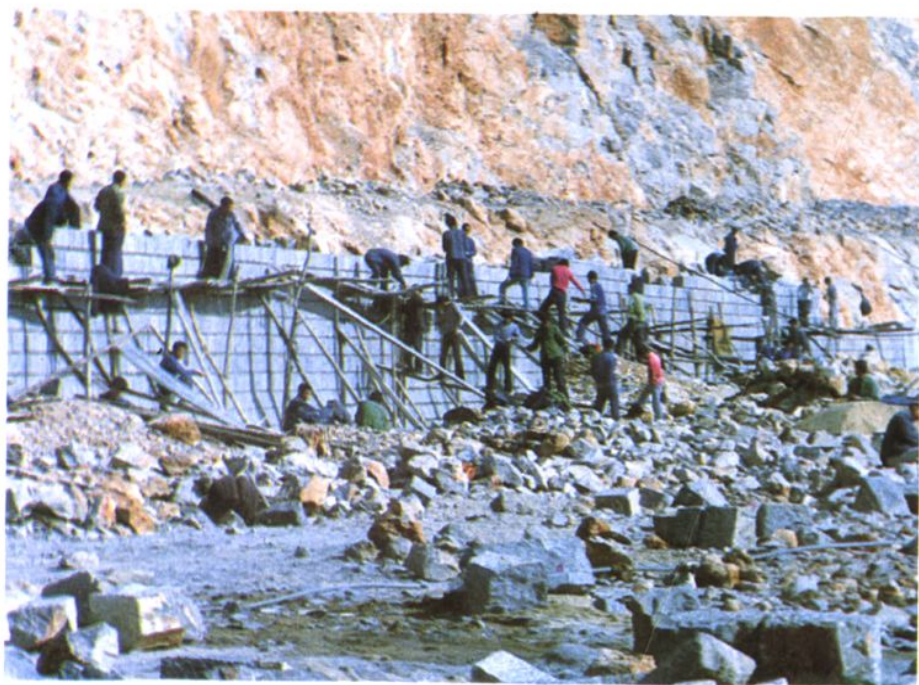
尼山水库渡讯工程施工现场
