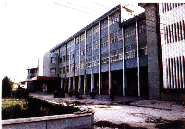
睢宁县棉纺织厂办公楼
