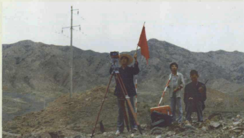
自治区电力设计院测绘人员在测量送电线路
