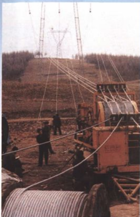
500千伏输电线路张力放线
