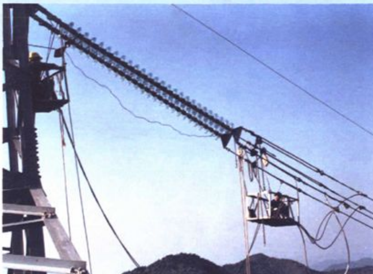
500千伏辽长吉哈佳输 电线路液压机高空压接
