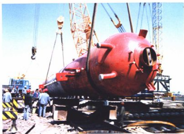
锅炉汽包吊装
