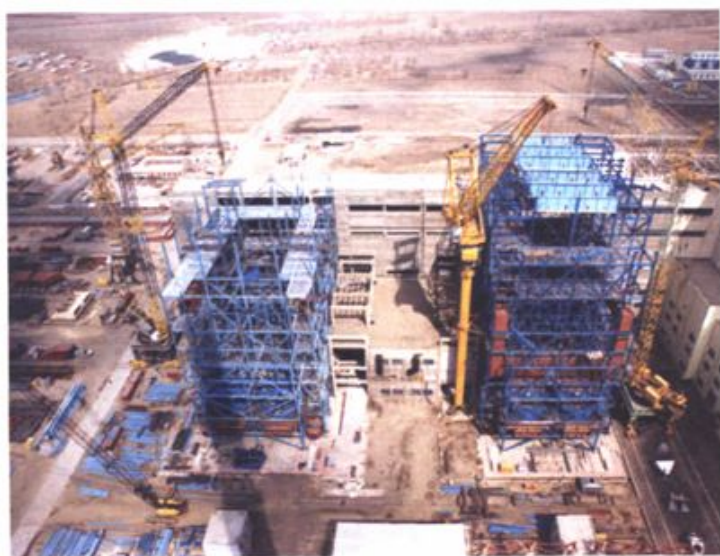
锅炉钢架吊装
