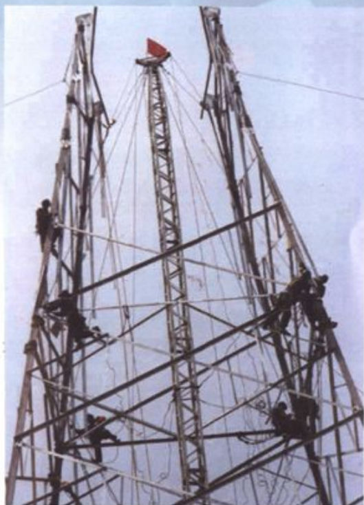
吉林省送变电公司工人正在进行组塔施工
