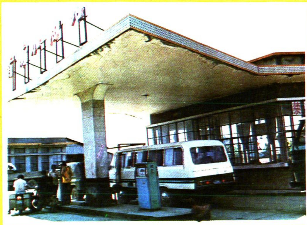
青浦县石油公司加油站
