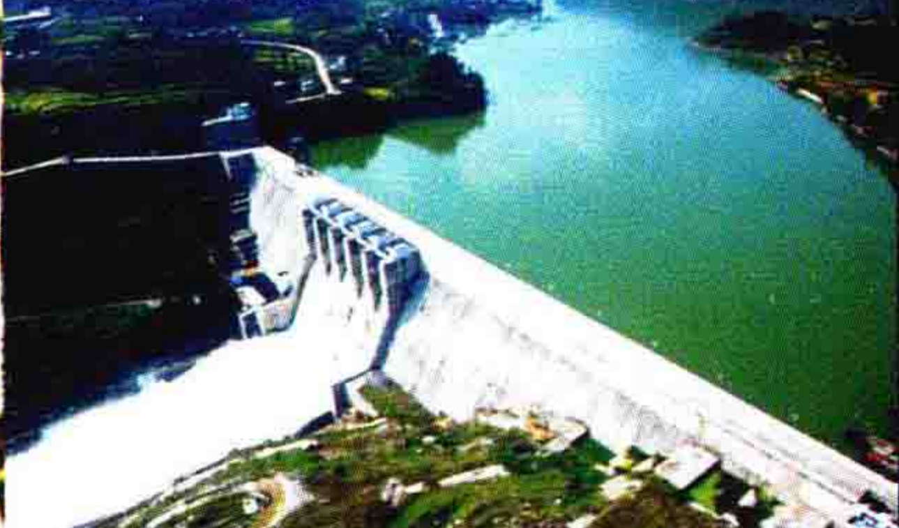
龙河石板水电站大坝(程必靖摄)
