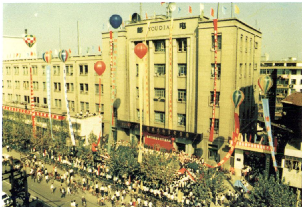
1960年4月动工建设的衡阳市邮电局解放路通信枢纽大楼。1992年10月2日程控开通庆典现场。
