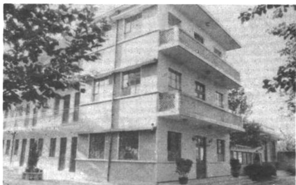
寿光县第二拖拉机配件厂办公楼
