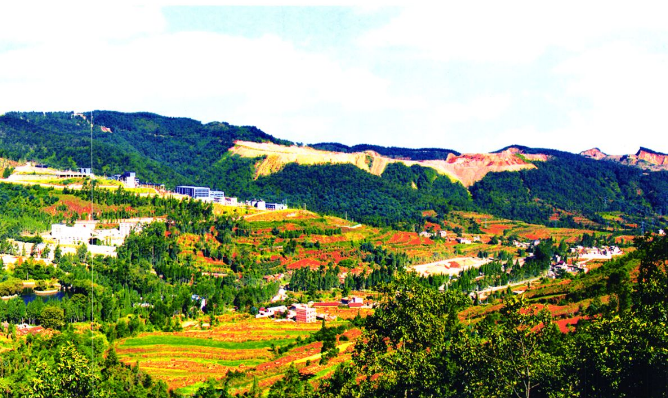
海口磷矿全景（拍摄于2009年10月）
