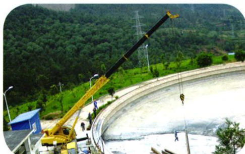
2010年8月，浮选厂检修沉淀池。
