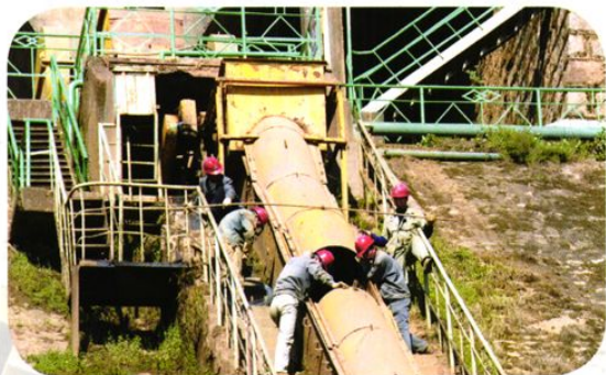
2009年3月，擦洗厂检修溜槽。
