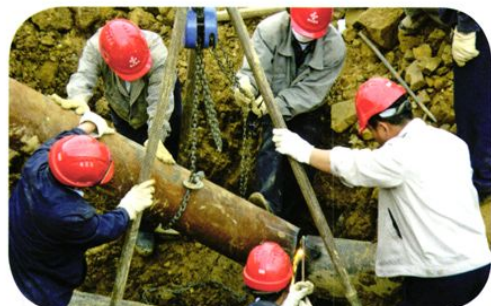
2009年7月，水电职工职工在抢修供水设施。
