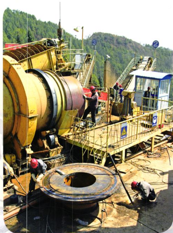
2008年3月，擦洗厂检修设备。
