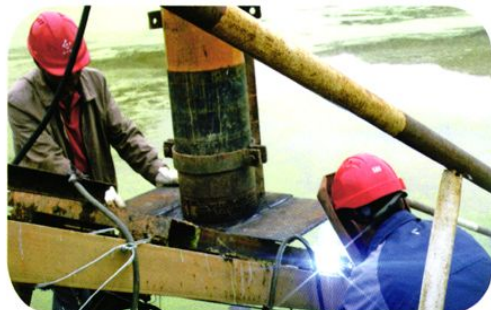
2009年6月，水电职工职工在抢修尾矿回水管。
