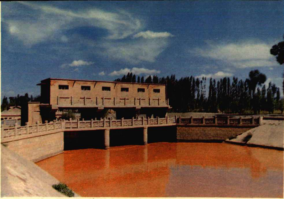
七星渠进水闸
