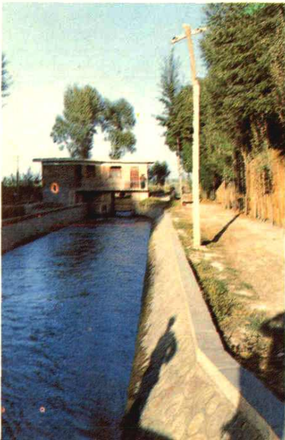
南北渠分水闸
