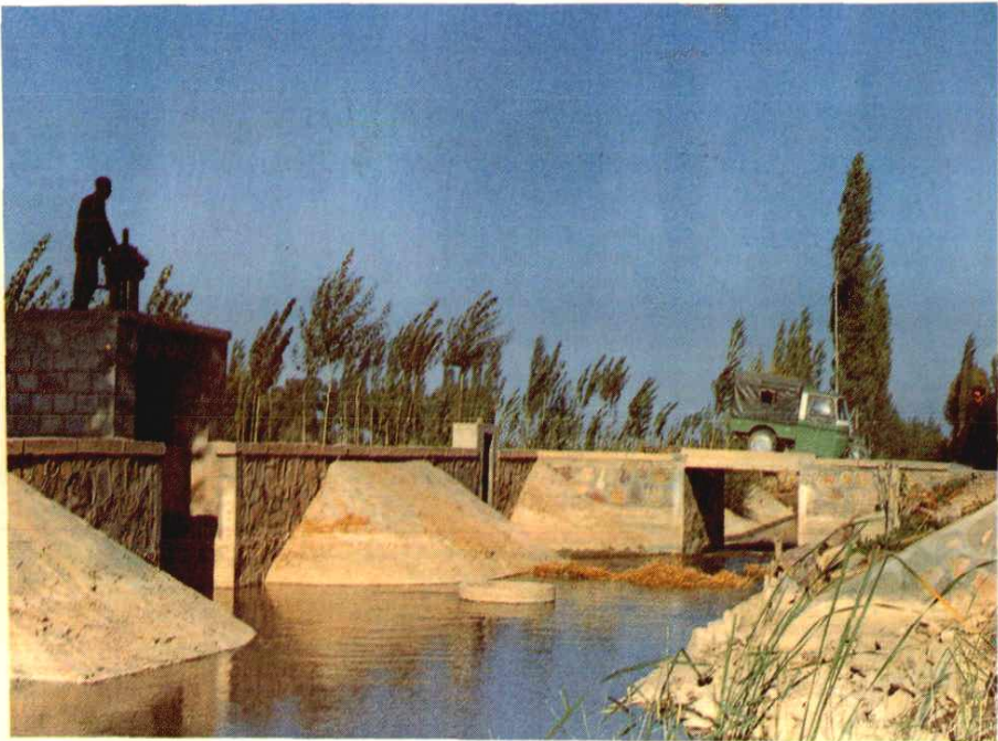
北滩渠分水闸
