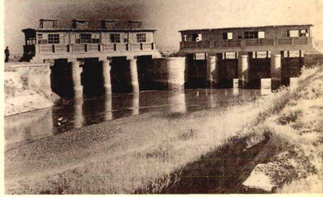
泉眼山老渠口闸
