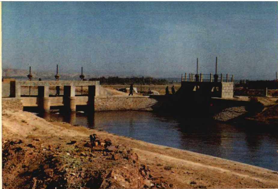
高支渠进水口
