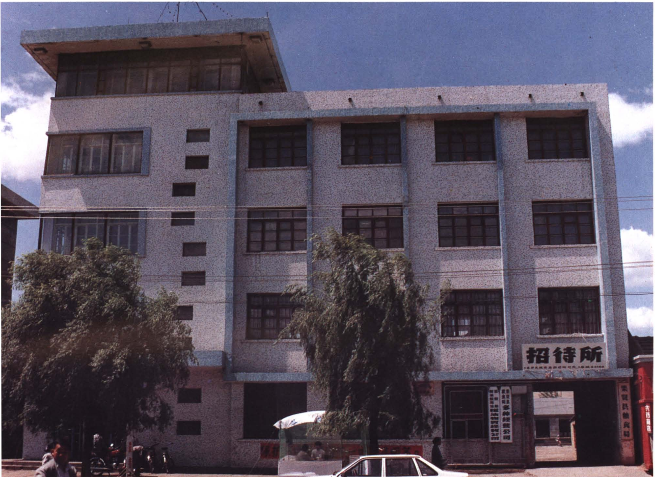
集贤县粮食局办公楼
