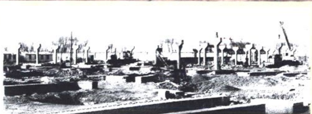
1988年，正在建设中的北厂区
