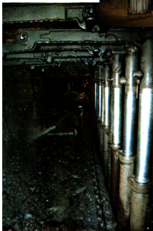
三矿井下单体液压支架工作面
