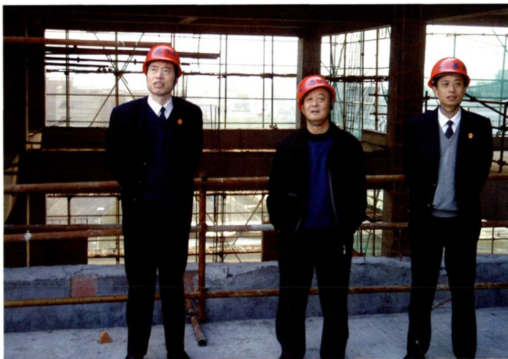
市中级人民法院院长王基信（中）视察我院新审判大楼施工工地（2007年3月）
