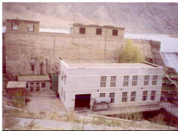
富蕴县一级水电站(装机容量 2400 千瓦)
