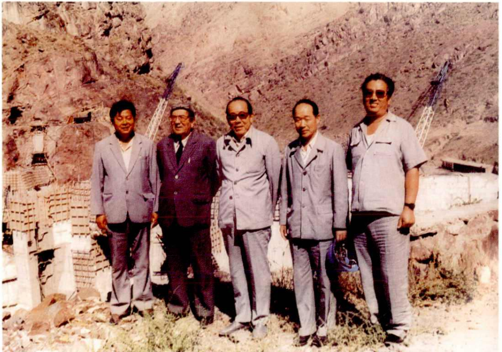
水利电力部副部长赵庆夫一行视察伊犁托海水电厂工地
