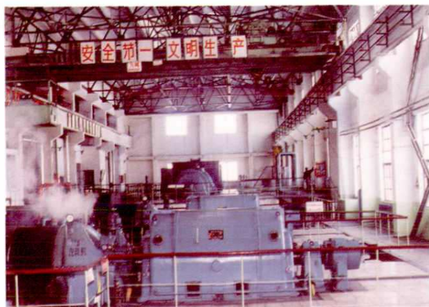
伊犁电厂汽轮发电机组
