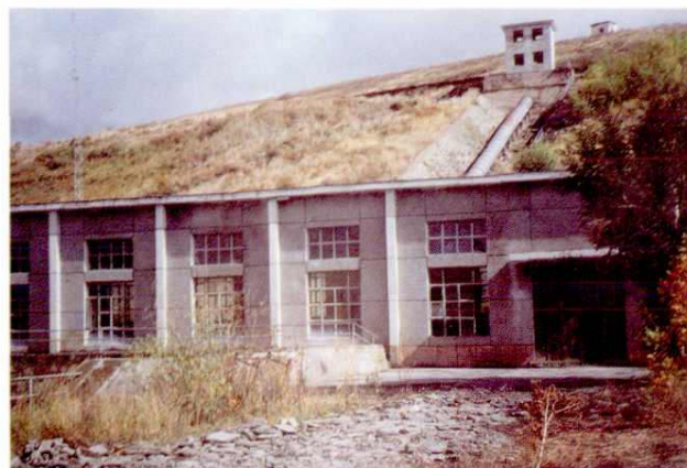
喀浪古尔水电站(装机容量 1050 千瓦)
