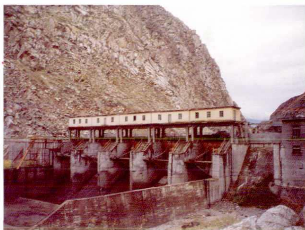
新疆有色金属公司可可托海水电站拦河坝 (装机容量 1.9 万千瓦)
