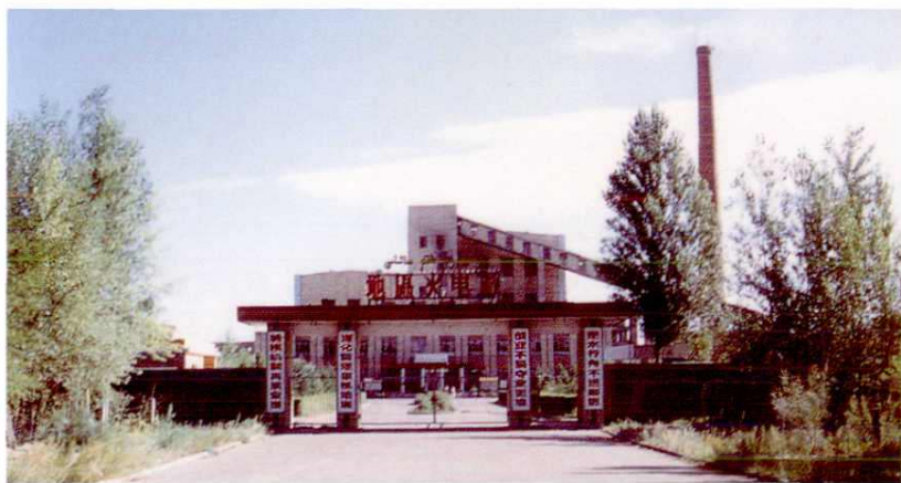
阿勒泰北屯火电厂(装机容量 1.2 万千瓦)
