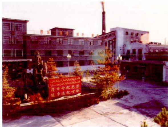
霍城电厂(装机容量 6000 千瓦)
