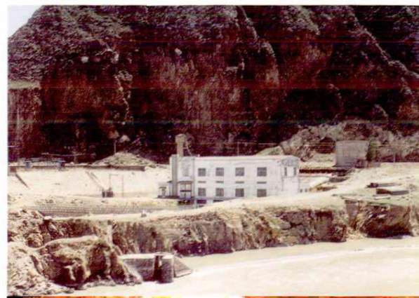
特克斯县库克苏水电站(装机容量 3200 千瓦)
