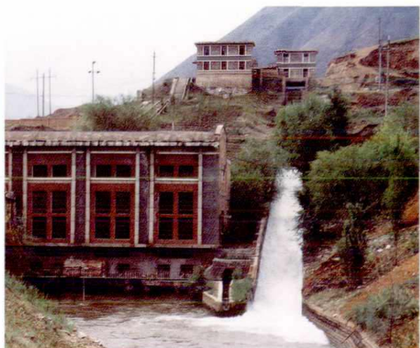
新源县卡普河四级水电站(装机容量 3600 千瓦)
