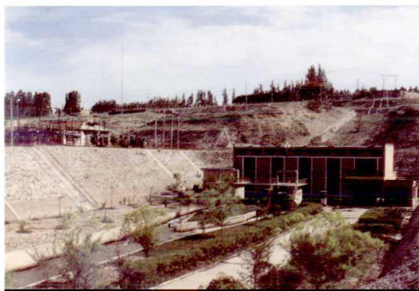
巩留县东风水电站(装机容量 2500 千瓦)
