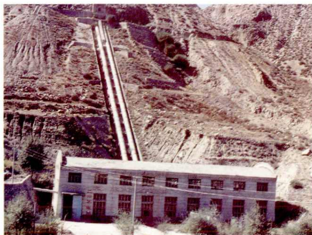
乌苏县四棵树二级水电站(装机容量 5000 千瓦)
