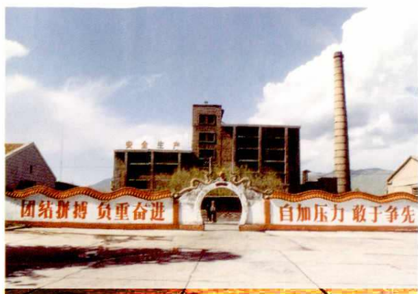
昭苏县电厂(装机容量 4500 千瓦)
