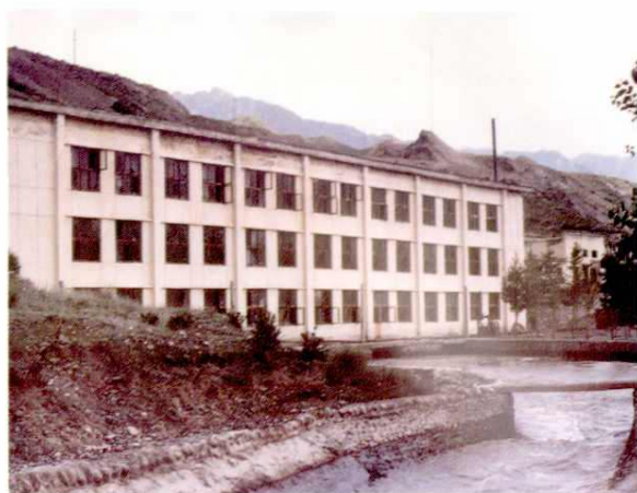
沙湾县金沟河一级水电站(装机容量 3800 千瓦)
