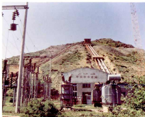
额敏县玛勒热苏二级水电站(装机容量 1500 千瓦)
