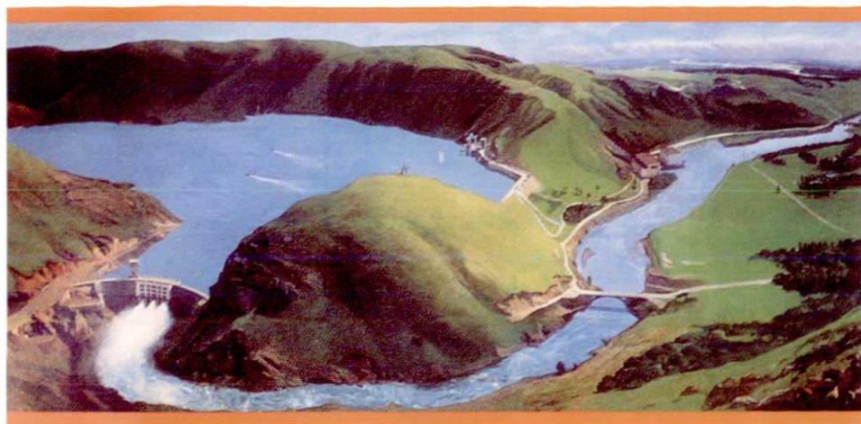
伊犁托海水电厂(装机容量 5 万千瓦)
