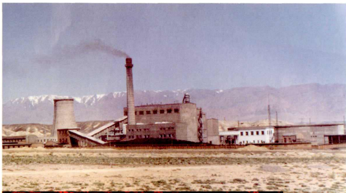
塔城铁厂沟电厂(装机容量 2.4 万千瓦)
