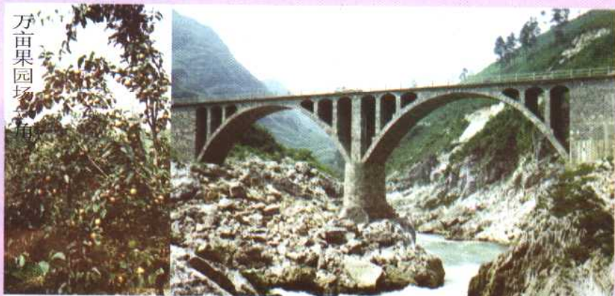
▲ 福开公路天生桥
