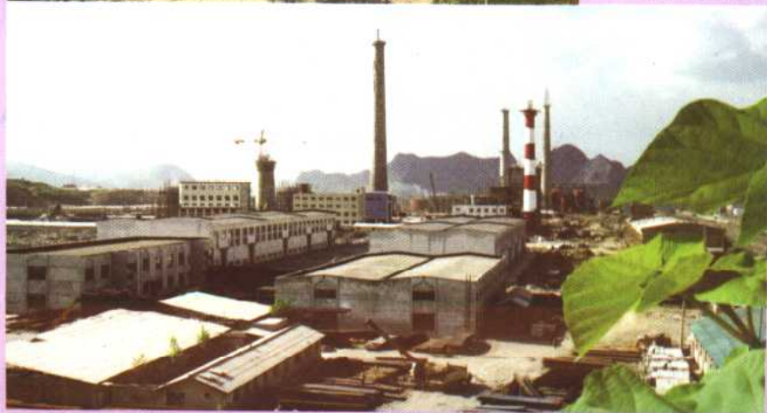
▼ 建设中的瓮福磷肥厂
