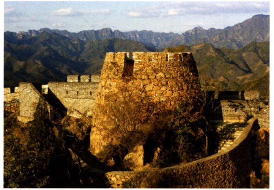
长城石砌墩台
