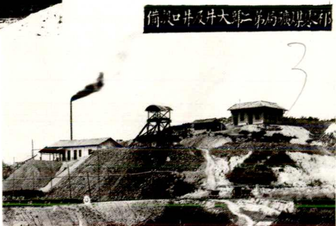
祁零煤矿局第二号大井及井口 设备
