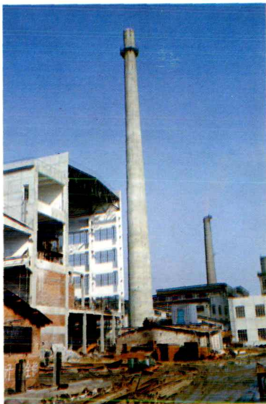
建设中的白沙发电厂
