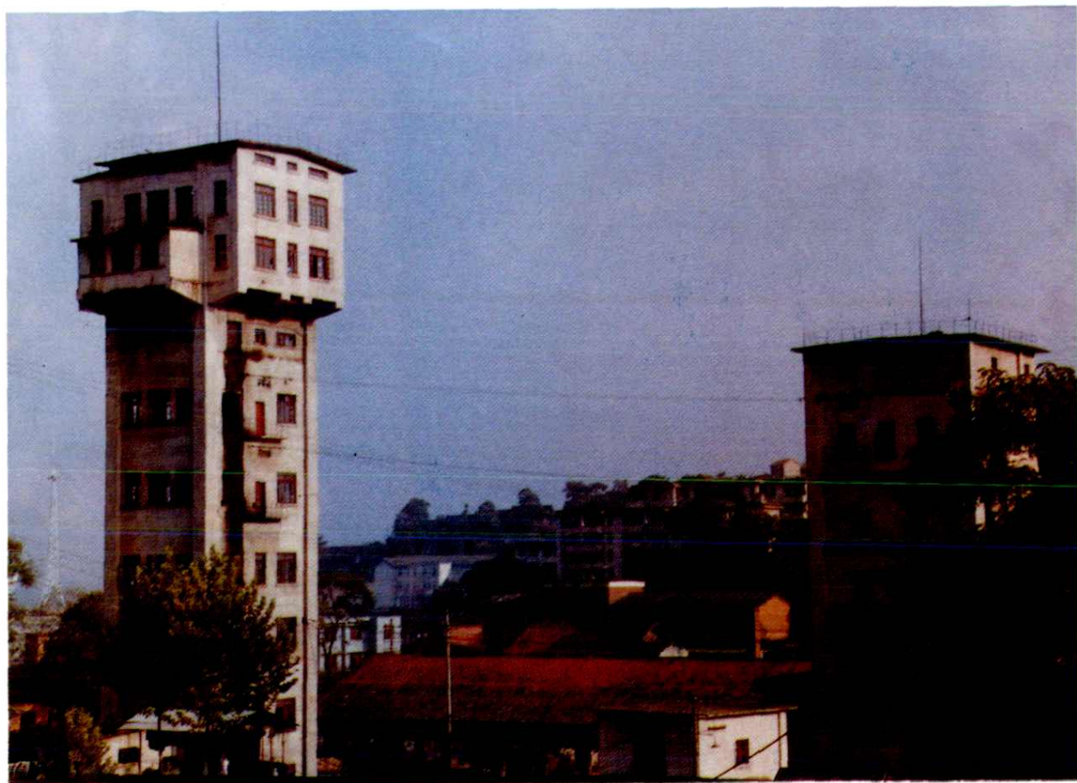
生产能力 45 万吨/年的资兴矿 务局周源山矿主、副井井塔
