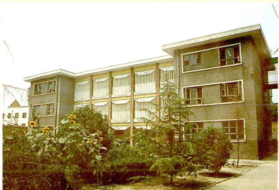
▶咸阳市社会福利院康 复大楼
