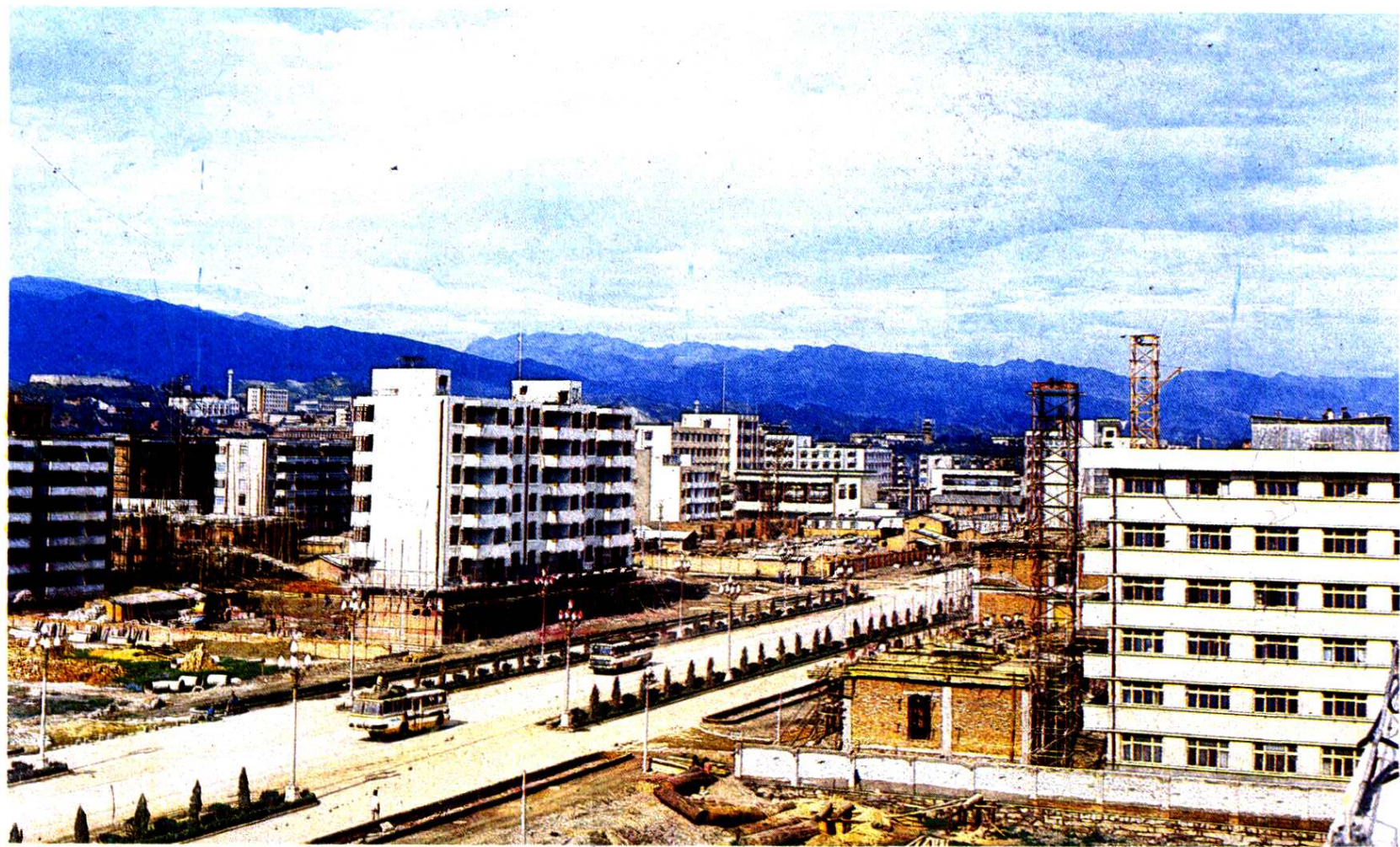
广元市城市新区建设
