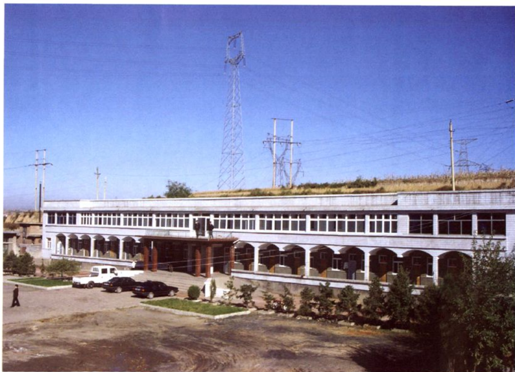
山西东升煤业集团东关煤炭发运站
