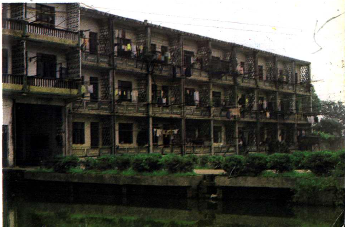
郊区净湘渔村渔民住宅 ▼
