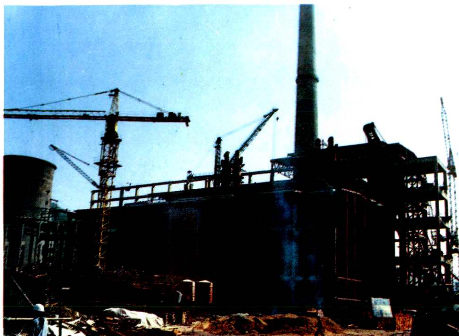
新热电厂施工场地一角
