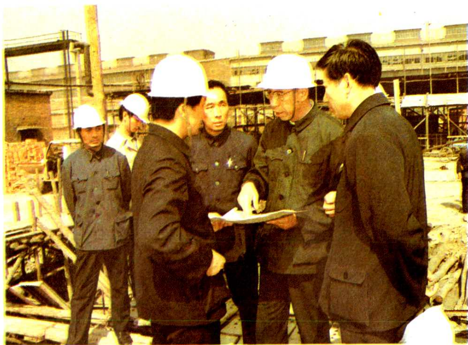
冶金部长戚元靖在本钢公司经理张文达 等陪同下视察发电厂新热电厂施工工地
