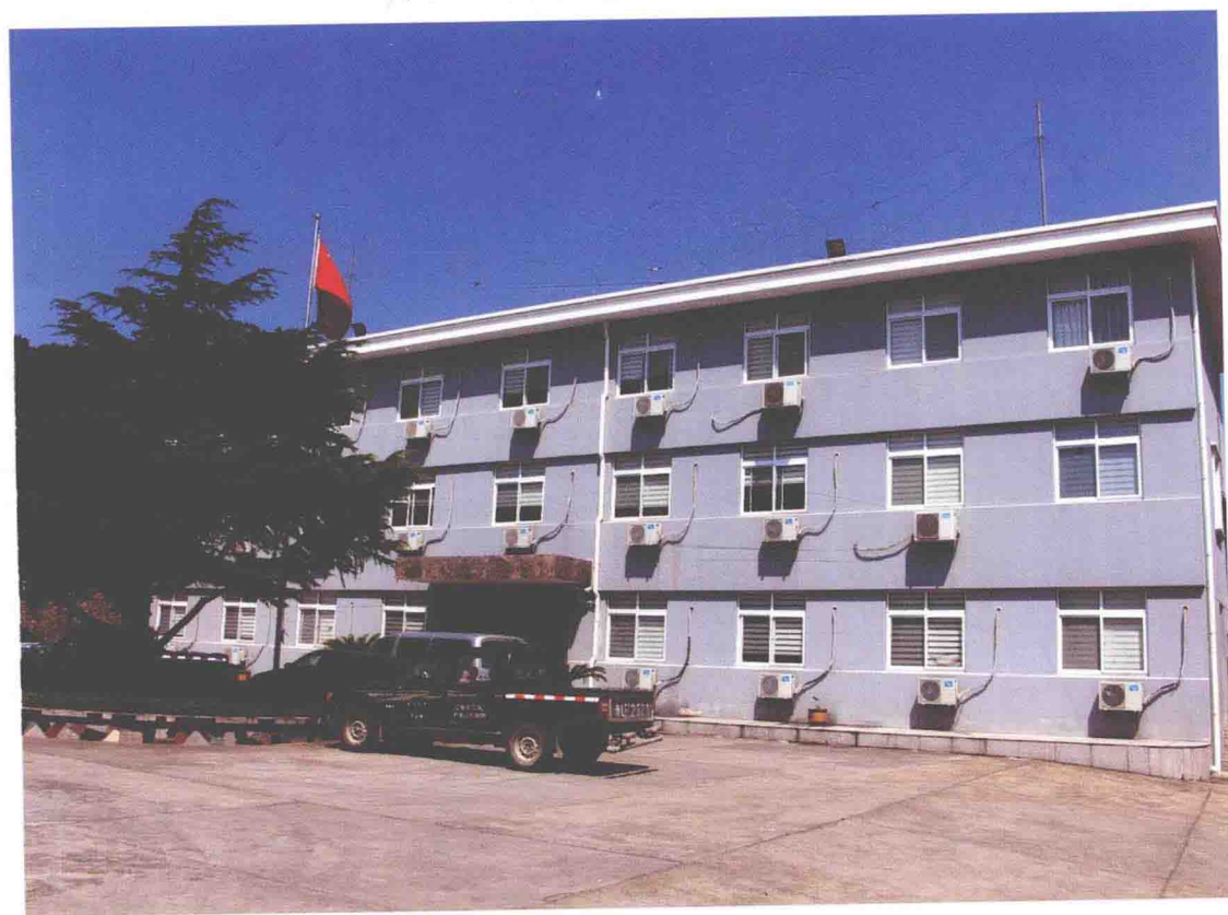
北蝉乡党、政机关办公楼
