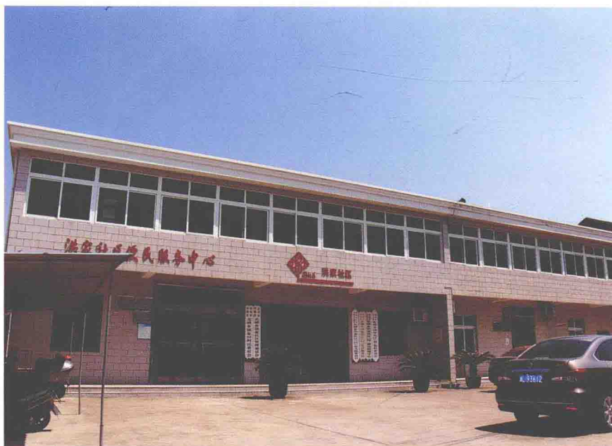
洪家社区办公楼
