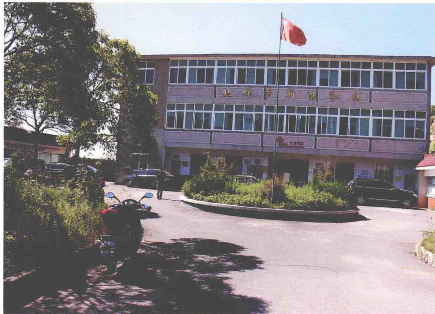
新港社区办公楼
