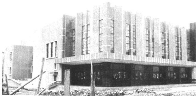
▶新建的影剧院
