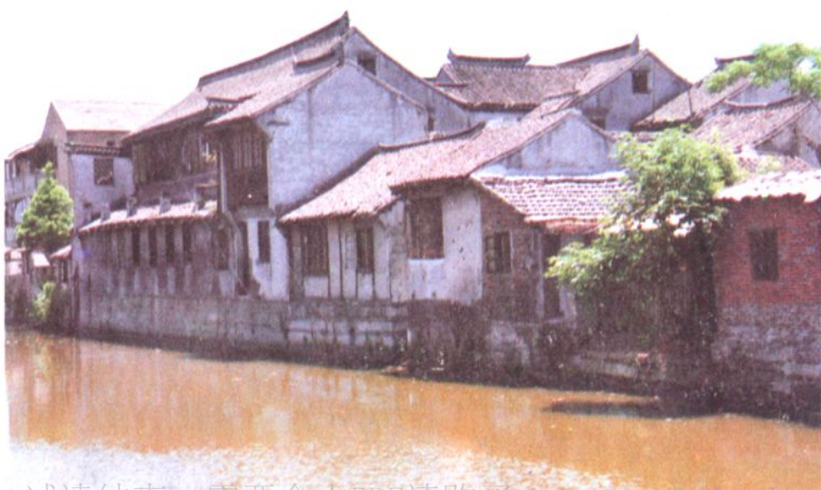
◀ 传统居民砖木结构住宅
