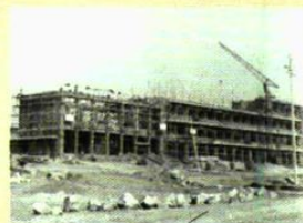
建设中的办公楼
