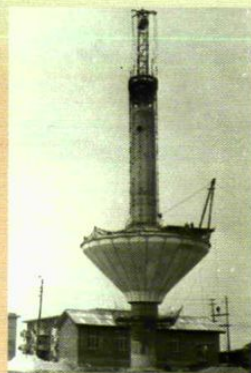
水塔正在建设中
