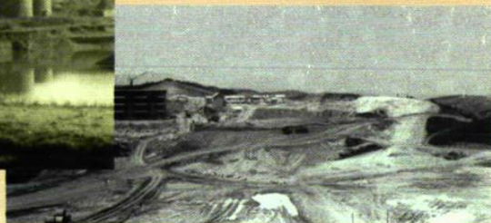
院址土方施工
