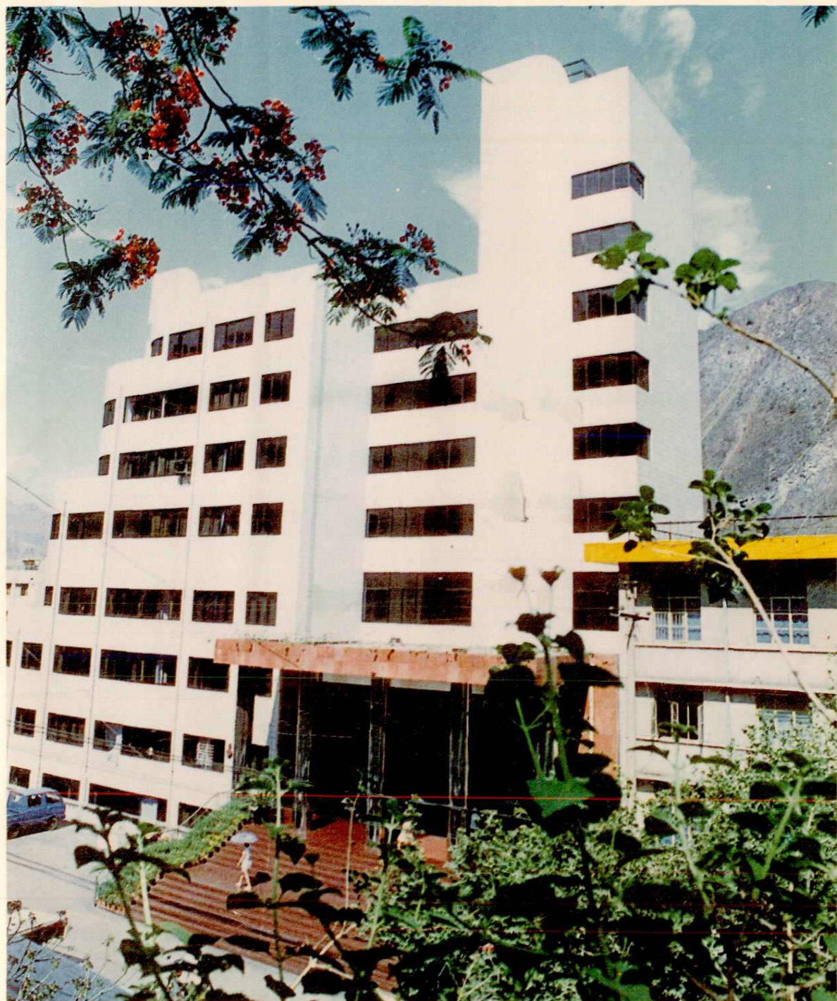
钢城企业总公司办公大楼
