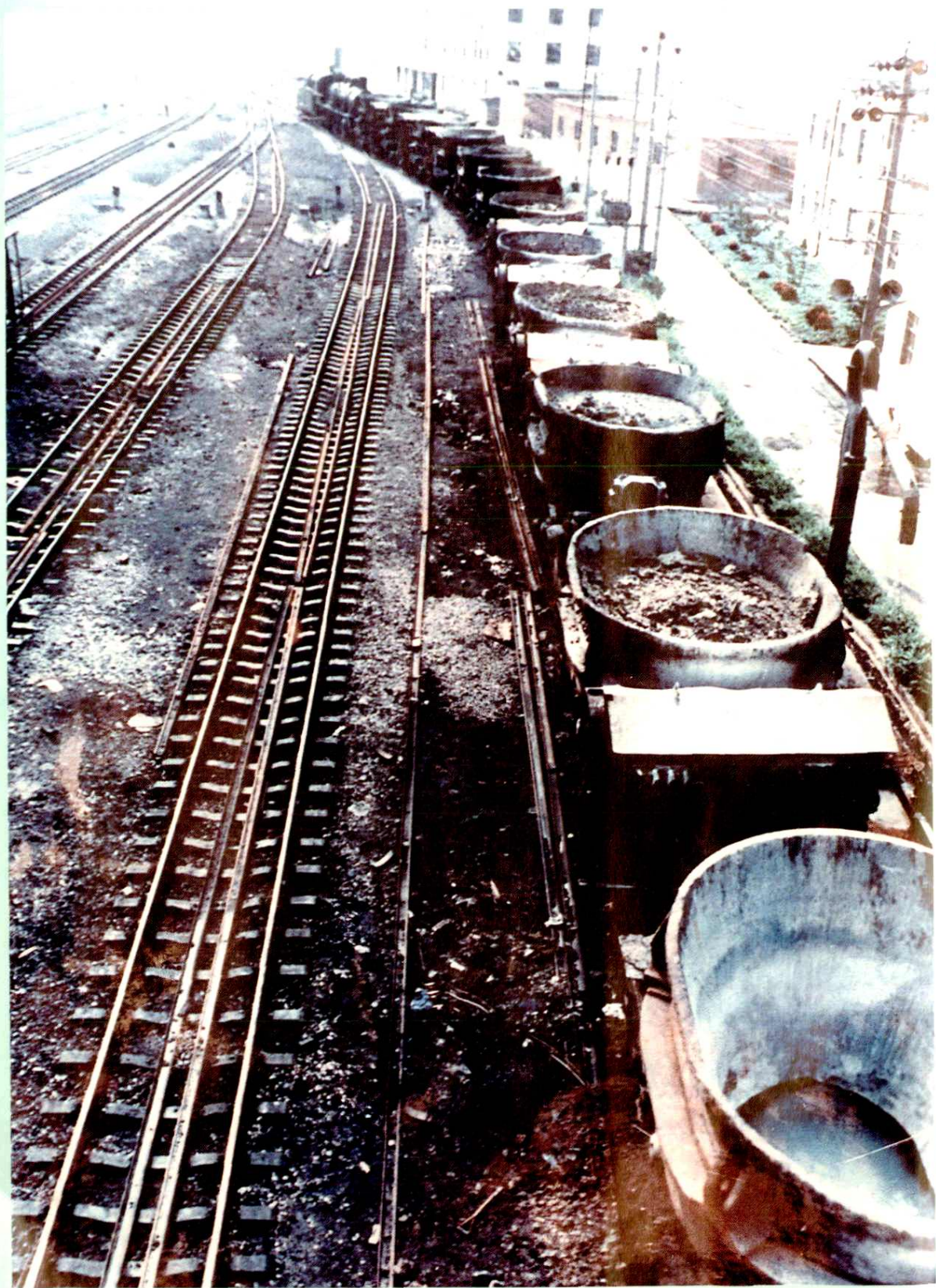
巴关河矿渣处理厂生产现场
