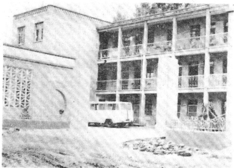
南阳县卫生学校门诊楼
