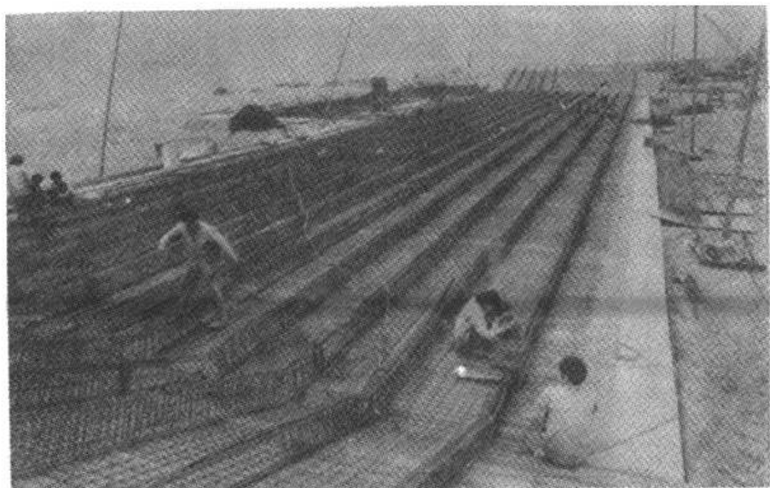
1971年泸州船厂水泥船施工工地
