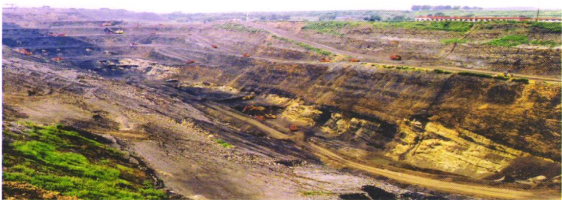
东露天矿全景
