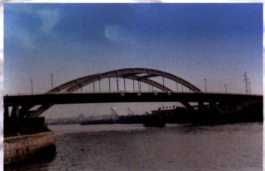
坛丘大桥 (摄于1998年)
