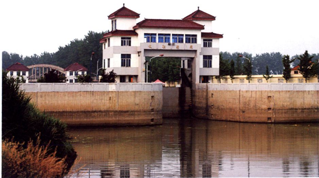
仪征套闸长期病患缠身,曾两度停航,2000年除险加固后面貌一新
