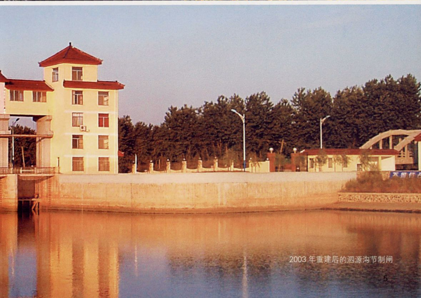
胥浦河节制闸——2002 年底拆除红旗漫水闸,在原址兴建,具有挡潮、排洪、引水、通航功能
