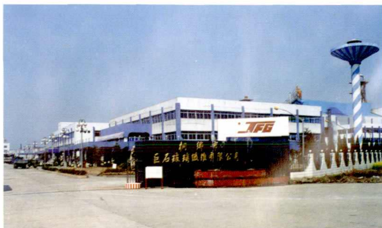
桐乡市巨石玻璃纤维有限公司
