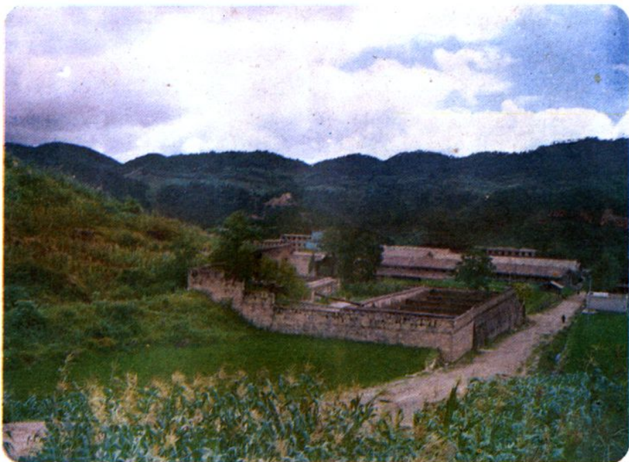
息烽县永靖镇人畜饮水工程大型地蓄水池
