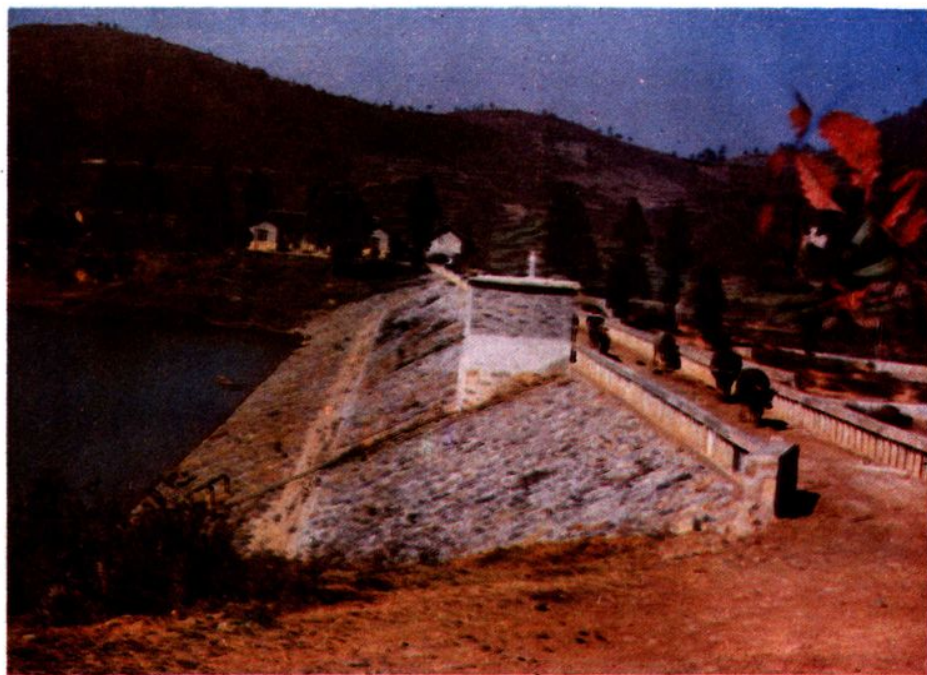
开阳县拐二水库
