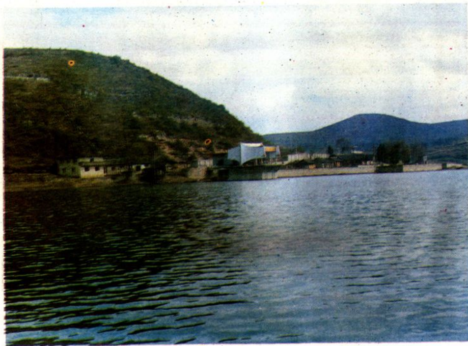
安顺地区猫猫洞水库
