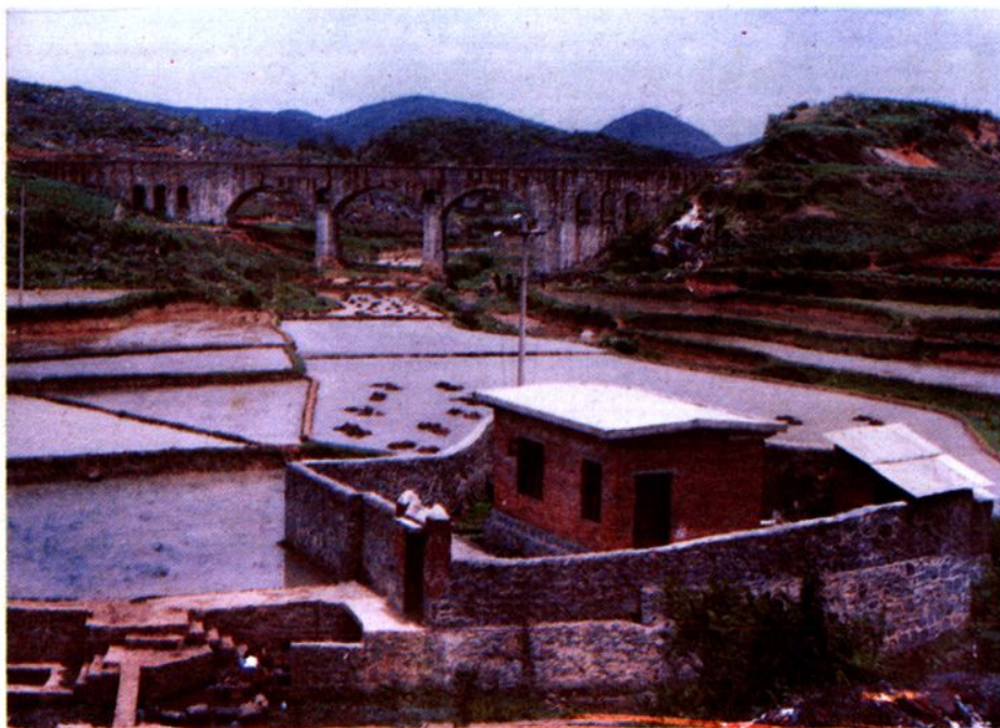
修文县久长人畜饮水工程给水池
